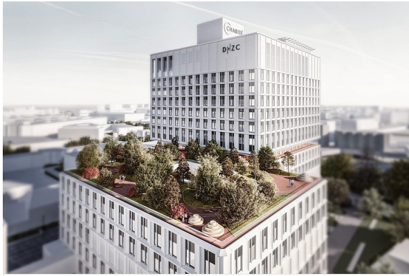
> Kapellmann unterstützt die Charité beim Neubau des Deutschen Herzzentrums
